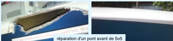
réparation d'un pont avant de 505
